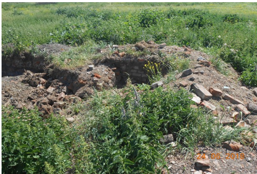
Рис. 2. Фундамент заброшенного дома в деревне Кукановка
